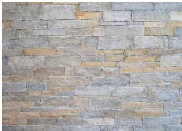
Pietra di Luserna (posa a muro)
